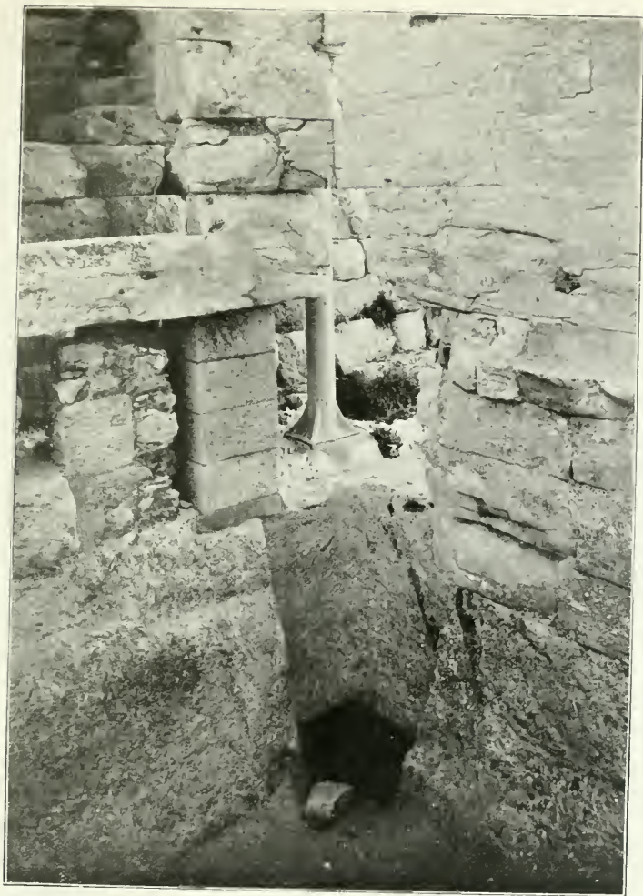
LA BRECHE DU MUR OCCIDENTAL DE L'ÉRECHTHEION. Vue de l'intérieur du Prostomaion.
